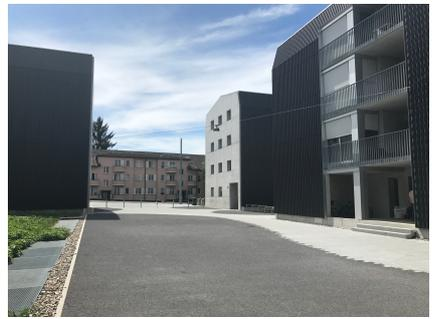
Dächer und die längsseitigen Fassaden sind als durchgehend strukturierte Fläche gestaltet. Die Aussenwände aus Holz tragen zu einem behaglichen Siedlungsambiente bei. Verkleidet wird die hinterlüftete Längsfassade mit einem hochwertigen Welleternit. Stirnseitig wird die ausdrucksstarke Sichtbetonfassade durchbrochen durch quadratische Fenster. Bei den stärker exponierten Gebäudefassaden sind akustische Schutzmassnahmen vorgesehen.
